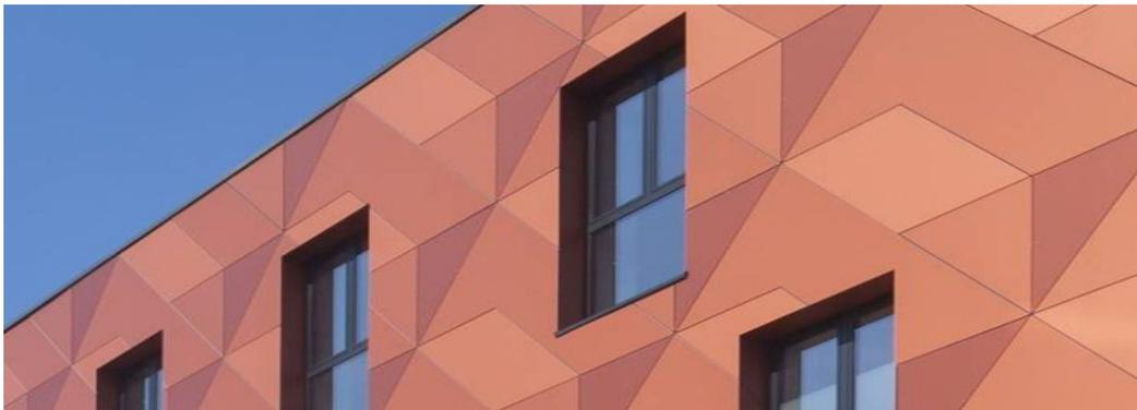
Farbige PV-Dünnschichtmodule an einem Gebäude
